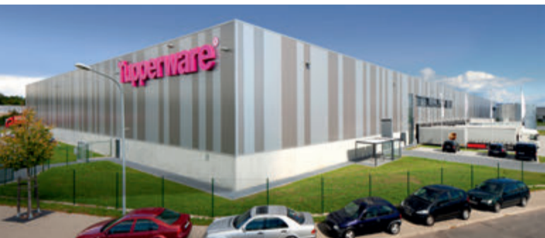
LIST BAU Bielefeld hat im Auftrag von Goodman im Rhein-Main-Gebiet eine Logistikimmobilie errichtet, die ein DGNB-Zertifikat in Silber erhalten hat.
