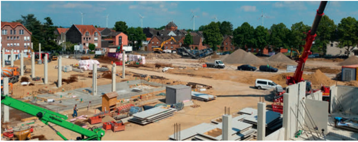
Seit Anfang März hat LIST BAU Nordhorn das Sagen auf der Baustelle „Am Feuerwehrturn“.
